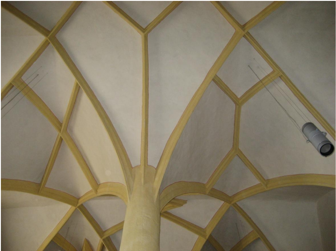
Abb. 5: Rippenansatz am Pfeiler, St. Rupert in Niederhofen.
