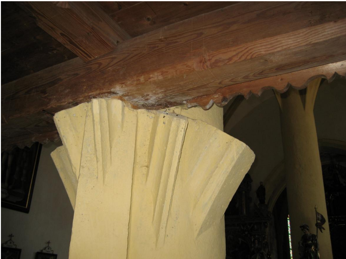
Abb. 4: Rippenansätze Westpfeiler, St. Rupert in Niederhofen.
